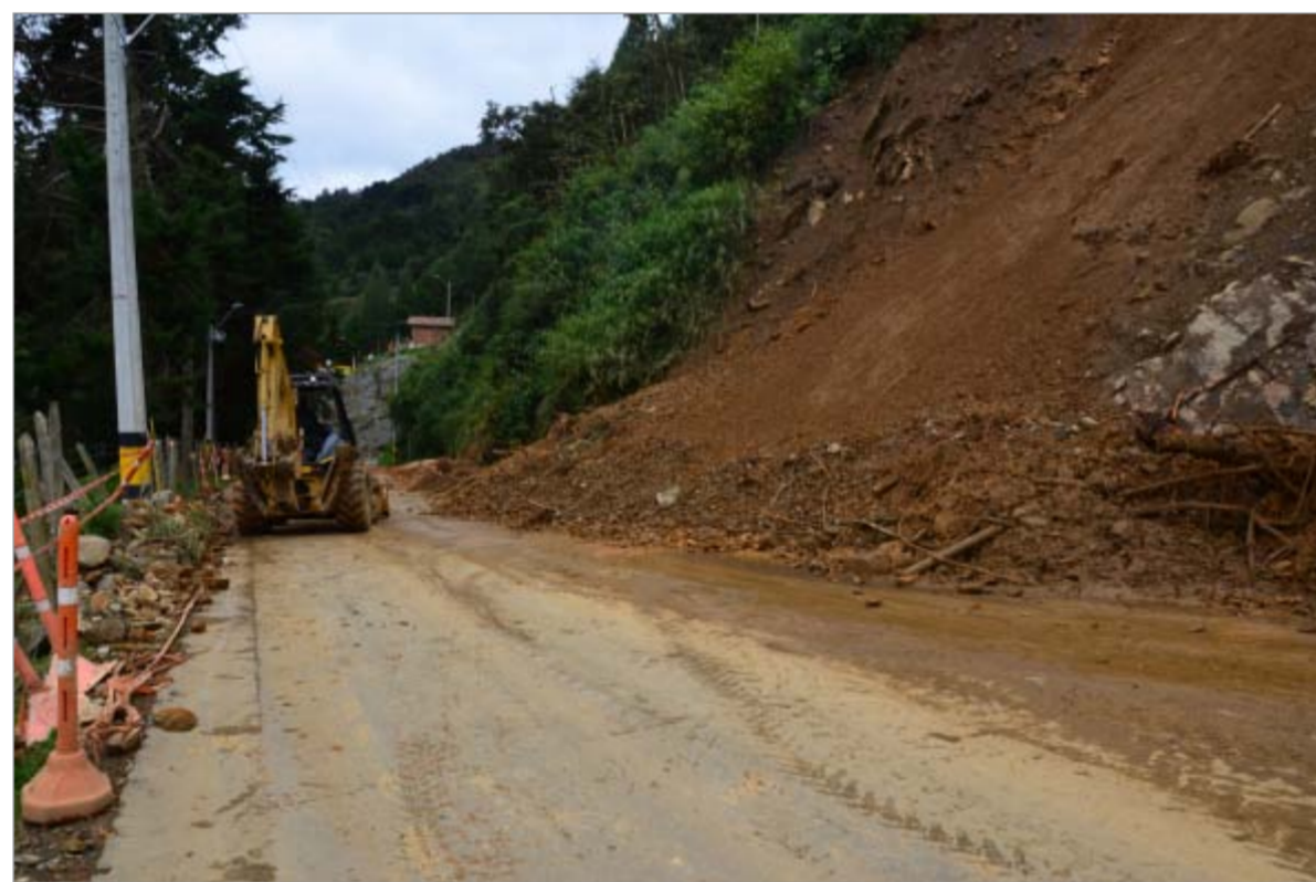
La retroexcavadora, recogiendo.
