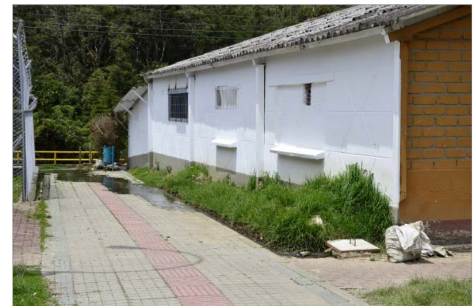
En otros casos, las aguas residuales corren por pleno parque.
