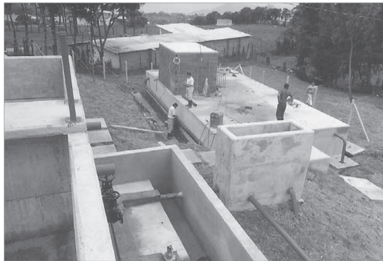
Construcción primer acueducto vereda El Llano, Santa Elena.
